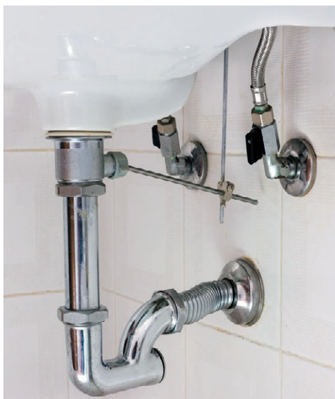
Рис. 10.10. Так выглядит смонтированный сифон
