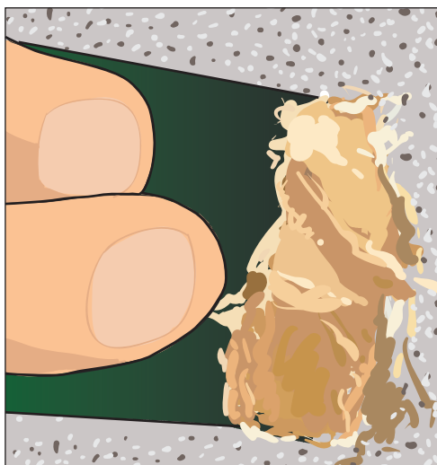
Рис. 1.54. Заполняем отверстие раствором
