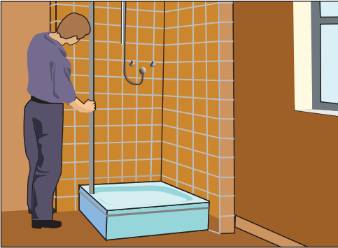
Рис. 10.216. Монтируем профили
