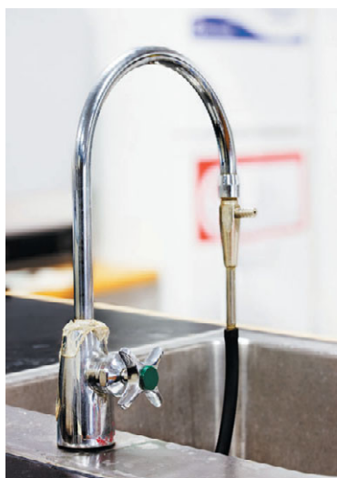
Рис. 10.1. Мелкий ремонт сантехники под силу каждому
