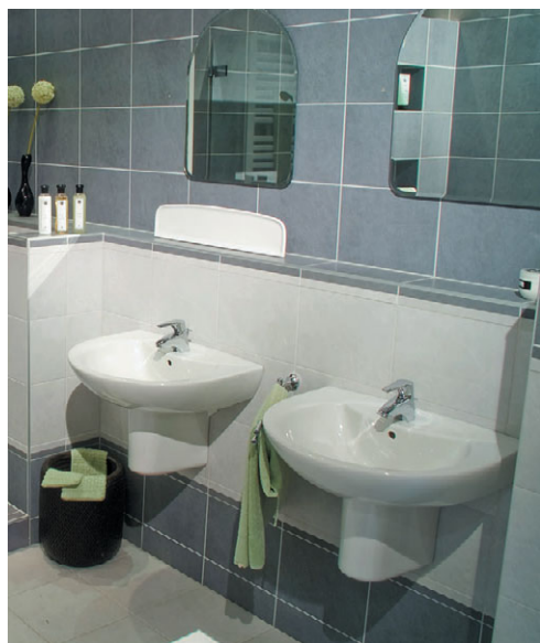
Рис. 10.68. Раковины на полупьедесталах в интерьере ванной комнаты
