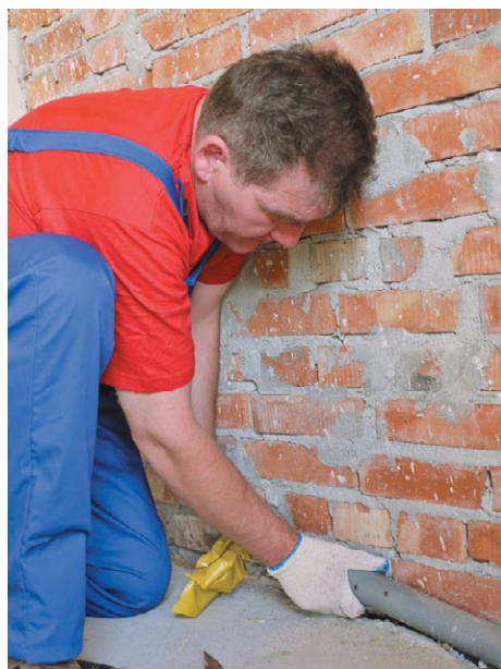
Рис. 8.22. Проверка стыков труб на герметичность
