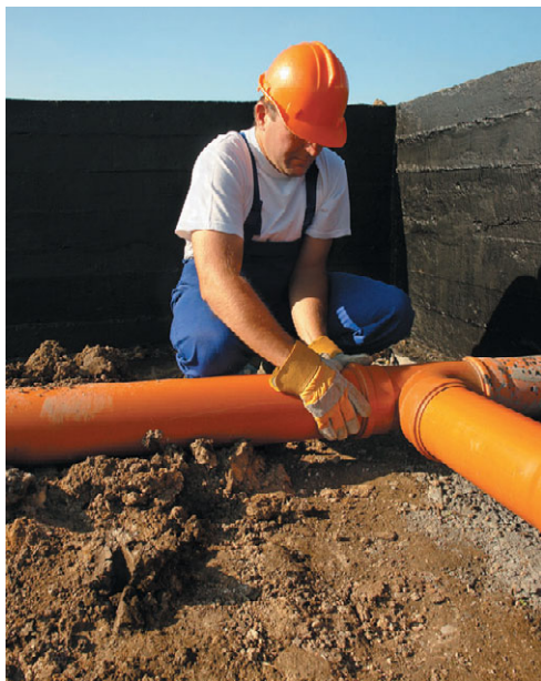
Рис. 8.2. Монтаж внутридомовых канализационных труб
