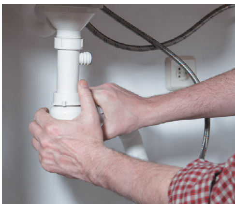
Рис. 10.78. Соединяем сифон со сливной трубой
