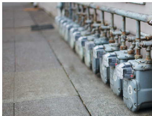
Рис. 3.6. Централизованная система газоснабжения в многоквартирном жилом доме
