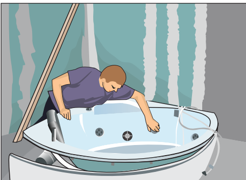
Рис. 10.190. Установка джакузи с декоративным экраном
