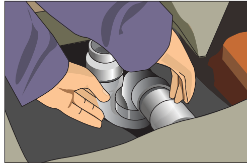
Рис. 10.179. Собираем и прикручиваем сифон
