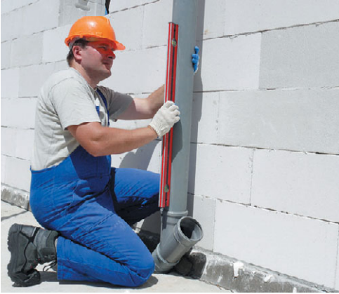
Рис. 8.3. Канализационный стояк
