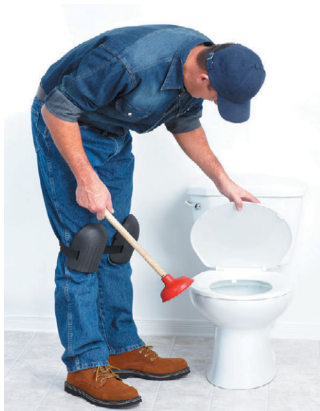
Рис. 8.20. Проверяем наличие засоров в унитазе
