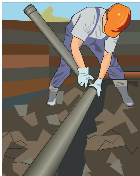
Рис. 8.37. Сборка труб в небольшие звенья по 3–4 штуки
