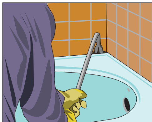
Рис. 10.161. Освобождаем стенки ванны от кафеля
