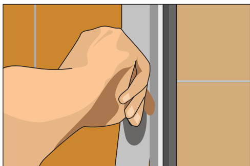
Рис. 10.223. Устанавливаем на место стыка резиновую ленту
