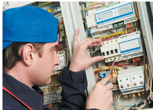
Рис. 10.305. Электрик подключает прибор к предохранительному автомату
