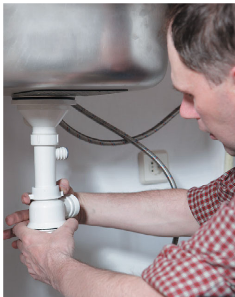
Рис. 10.77. Плотно прижав стакан к трубе, закручиваем гайку
