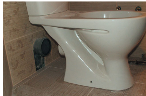
Рис. 10.88. Унитаз с горизонтальным выпуском
