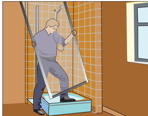
Рис. 10.221. Закрепляем двери
