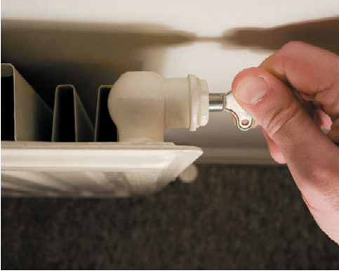
Рис. 12.52. Выпуск воздуха из радиатора (слева) с помощью специального крана (справа)
