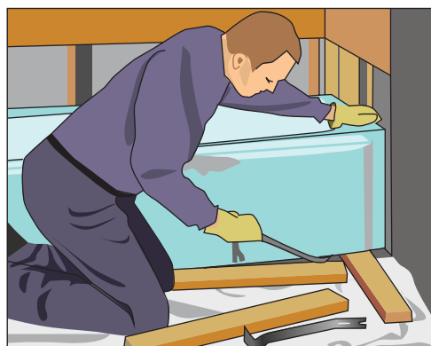
Рис. 10.162. Снимаем ванну
