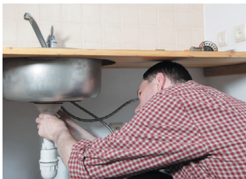
Рис. 10.75. Накручиваем на сливную трубу под мойкой гайку и плотно ее затягиваем
