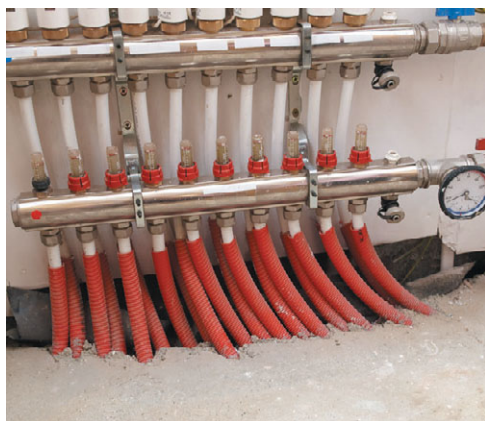
Рис. 12.11. Готовая стяжка и распределительная система пола
