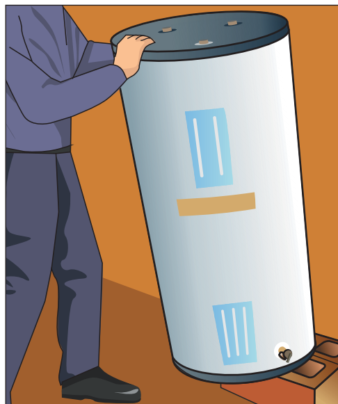
Рис. 10.283. Устанавливаем водонагреватель большого размера на смонтированную напольную подставку
