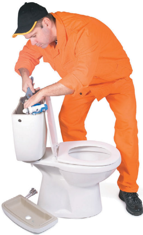
Рис. 11.63. Ремонт сливного бачка доступен не только сантехнику
