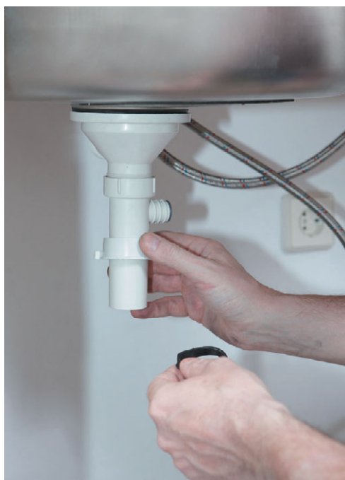
Рис. 10.76. Надеваем уплотнительное кольцо
