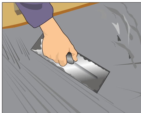
Рис. 12.6. Очистка застывшей цементной стяжки
