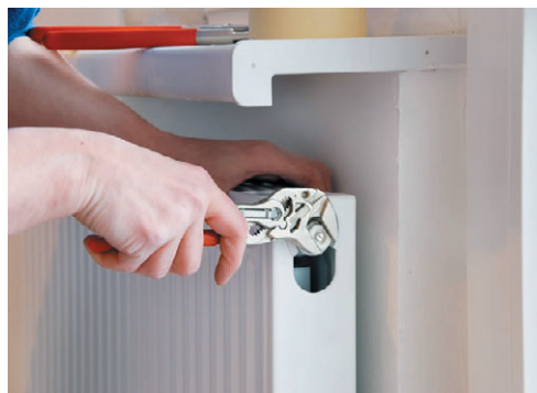
Рис. 3.3. Монтаж системы отопления
