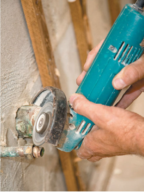
Рис. 1.15. Резка трубы с помощью болгарки
