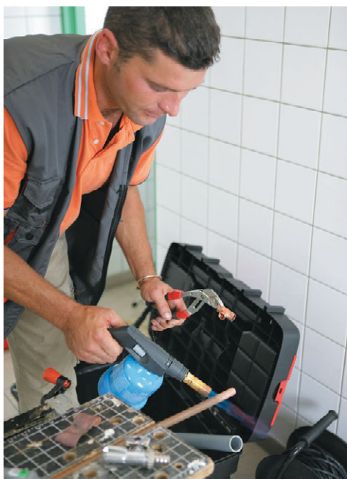
Рис. 4.54. Разогреваем трубу
