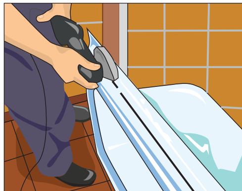
Рис. 11.92. Подрезаем борта вкладыша
