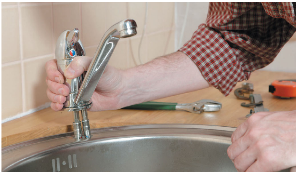
Рис. 10.14. Демонтаж старого смесителя на узкой основе
