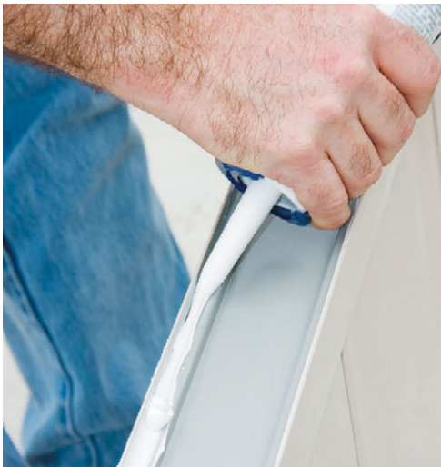
Рис. 1.35. Нанесение силиконового герметика
