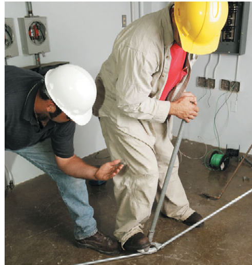
Рис. 1.11. Гибка трубы с помощью трубогиба
