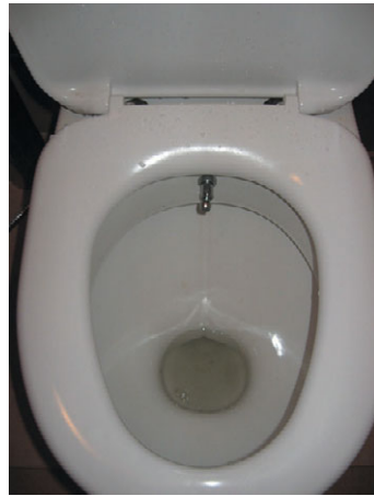
Рис. 10.153. Унитаз-биде (в центре — кран для подачи воды)
