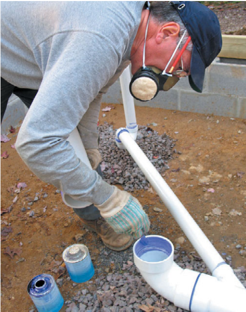
Рис. 4.64. Склеивание труб пластикового водопровода:
