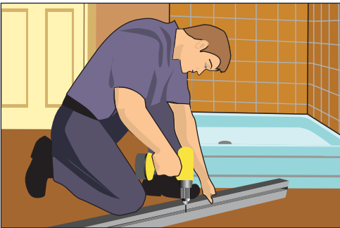
Рис. 10.217. Сверлим отверстия в профилях для крепления
