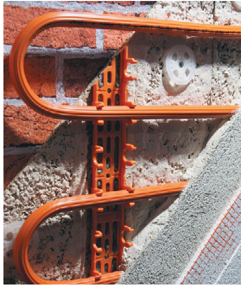
Рис. 12.19. Укладка гибких труб «змейкой» и последующая отделка стен
