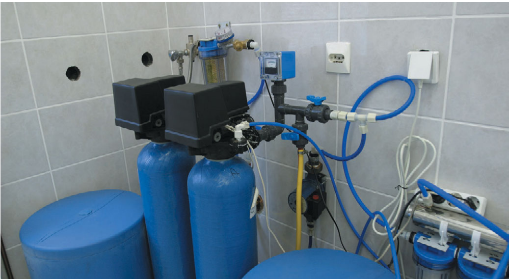
Рис. 7.1. Система многоступенчатой очистки воды
