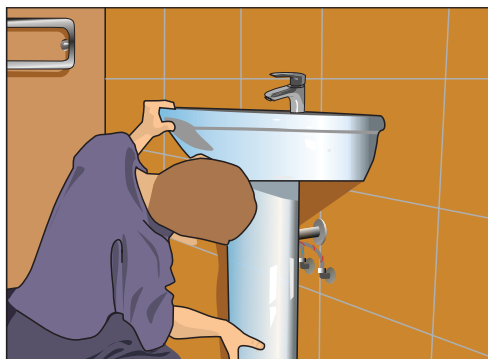
Рис. 10.66. Устанавливаем пьедестал
