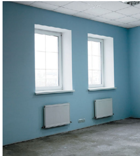
Рис. 12.50. Радиатор, установленный под окном, теряет 3–4 % тепла
