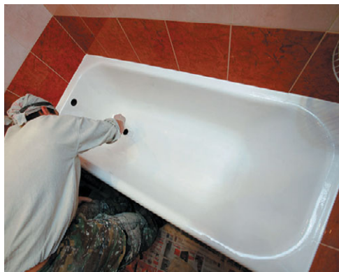
Рис. 11.89. Реставрация старой ванны с помощью эмали
