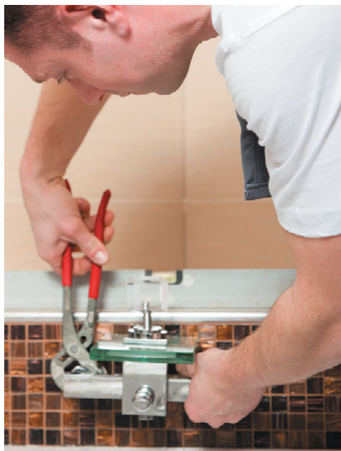
Рис. 11.26. Ремонт смесителя
