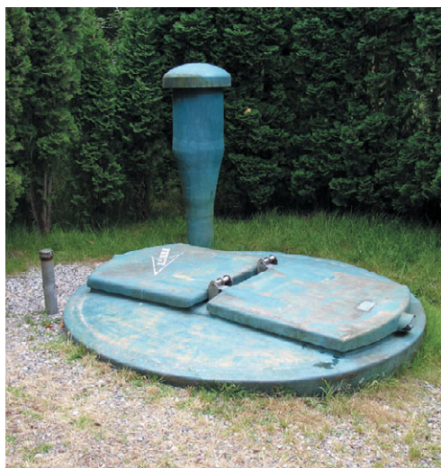
Рис. 8.31. Фильтрационный колодец
