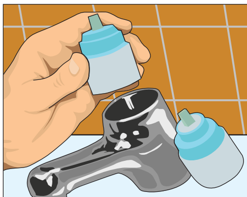
Рис. 11.31. Снимаем старый картридж, на его место устанавливаем новый
