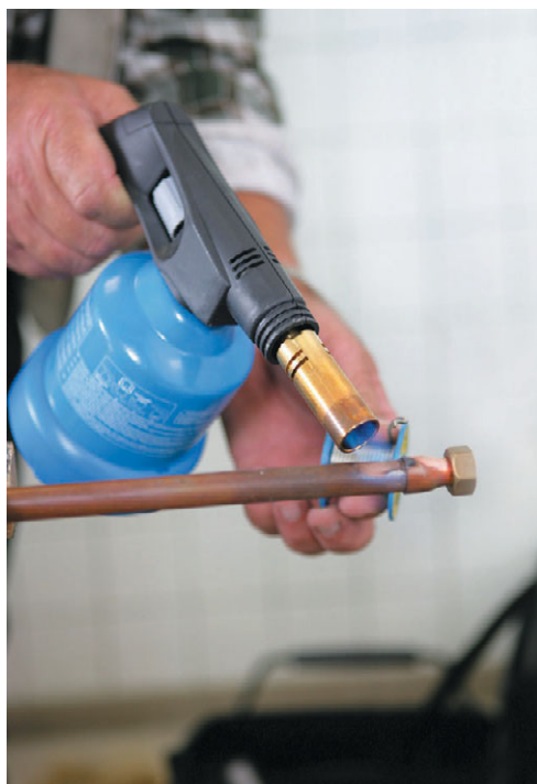
Рис. 4.55. Расплавляем припой в зазоре между фитингом и трубой
