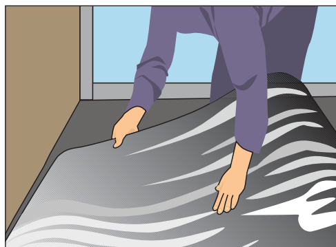
Рис. 12.16. Укладываем вспененный полиэтилен, покрытый алюминиевой фольгой
