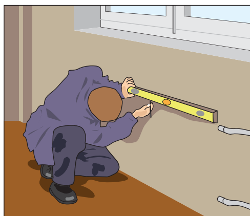
Рис. 12.54. Проводим горизонтальную линию крепления радиатора
