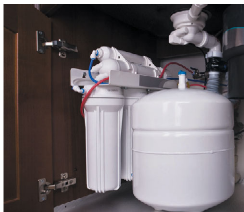
Рис. 7.7. Система фильтрации воды в доме
