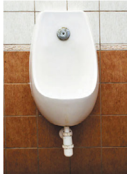
Рис. 9.124. Модель настенного писсуара с наружным пластиковым сифоном
