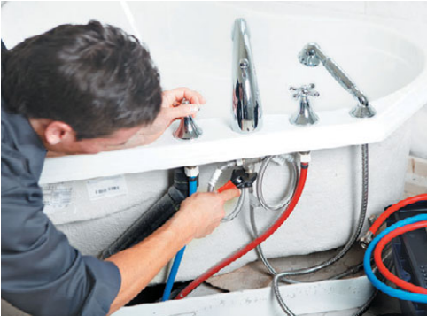
Рис. 2.7. Самостоятельное проведение сантехнических работ
