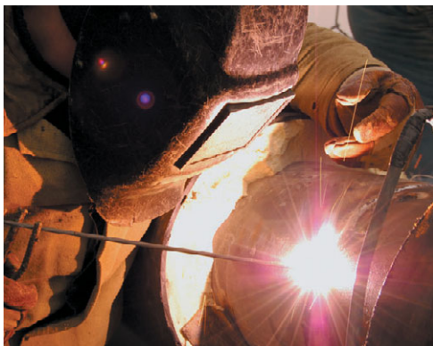
Рис. 4.50. Выполнение сварочных работ квалифицированным специалистом
