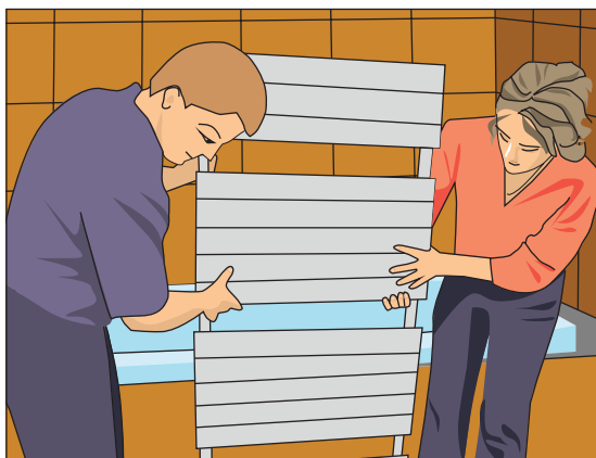
Рис. 12.74. Большой полотенцесушитель устанавливаем вдвоем
