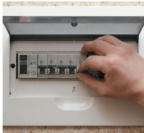
Рис. 10.274. Отключение щитка перед началом соединения
