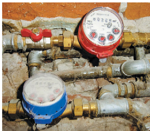
Рис. 6.1. Счетчики горячего и холодного водоснабжения
