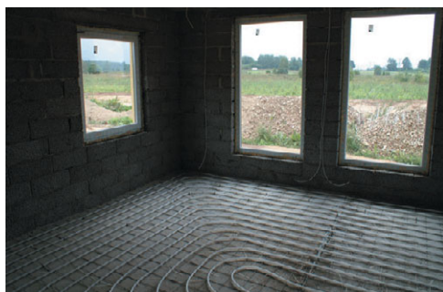
Рис. 12.2. Устройство теплого пола в собственном доме
