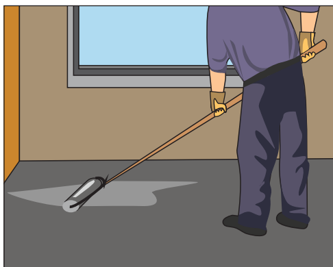
Рис. 12.4. Грунтование бетонного основания
