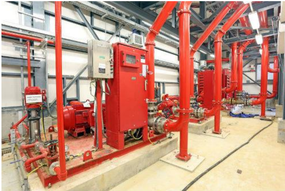
Пожарная насосная станция
